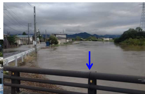
和田川出水状況 (高畠町夏茂地内)
