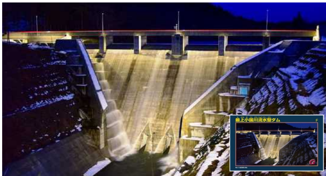
堤体整備状況(下流より)
