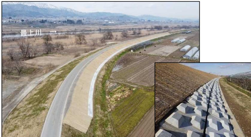
堤防強化対策（堤防法尻補強 最上川右岸）
