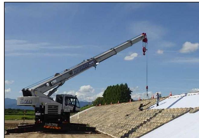
堤防強化対策（堤防浸透対策 最上川右岸）
