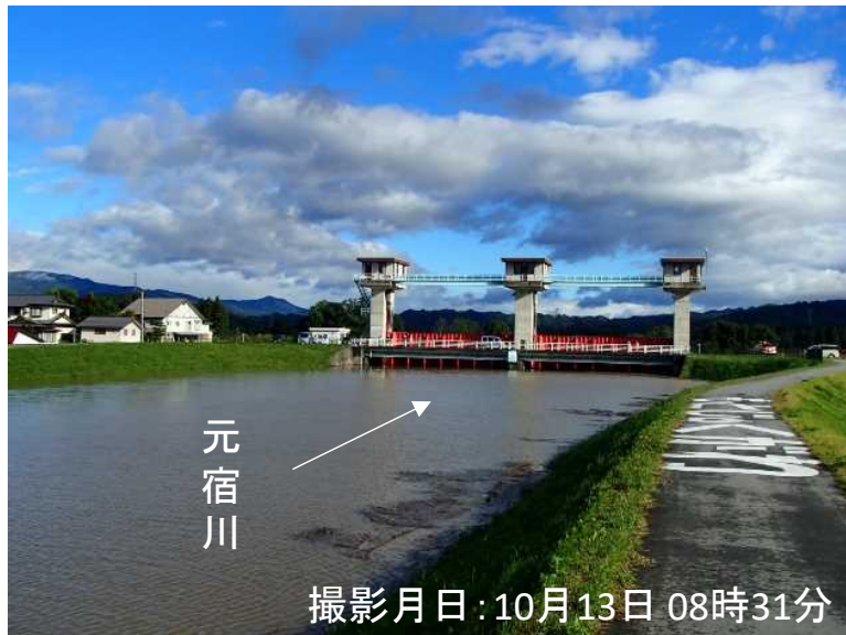
もとじゅくがわ 元宿川水門 最上川水系 もとじゅくがわ 元宿川右岸堤防より
