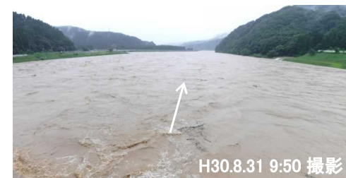
▲最上川 さみだれ大堰から下流を望む
