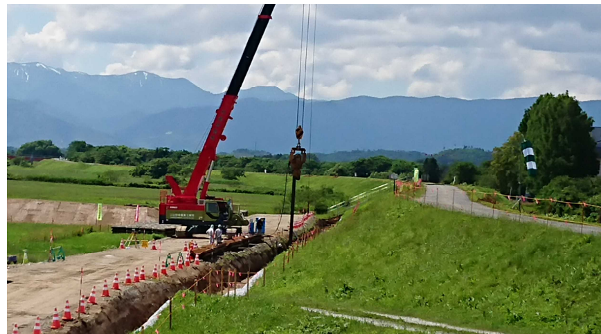
堤防強化対策（堤防浸透対策 最上川右岸）
