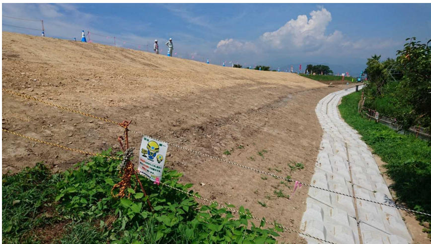
堤防強化対策（堤防法尻補強 村山野川右岸）
