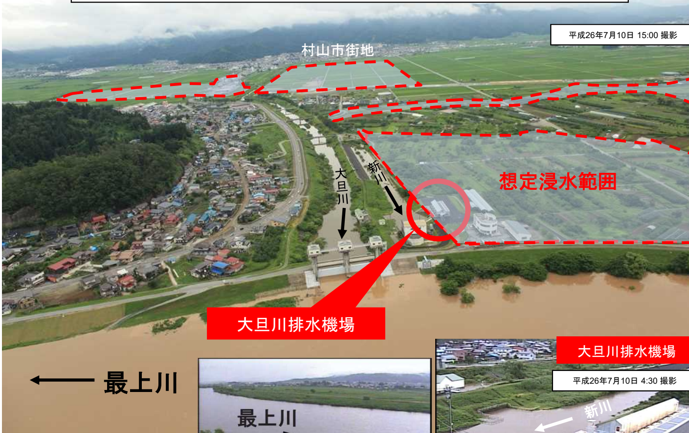
排水機場が無かった場合の想定浸水範囲(平成26年7月出水)
