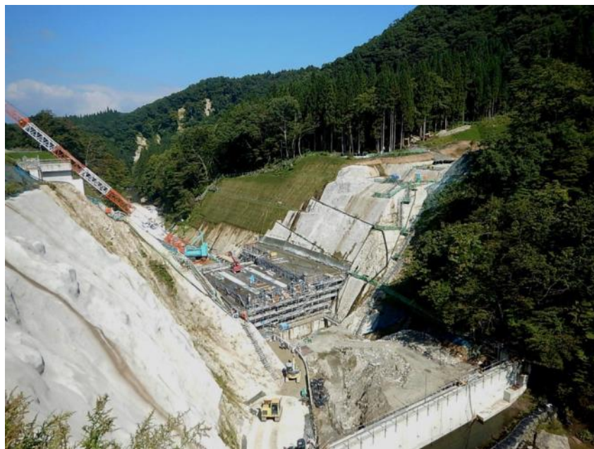
堤体コンクリート打設状況（下流より）
