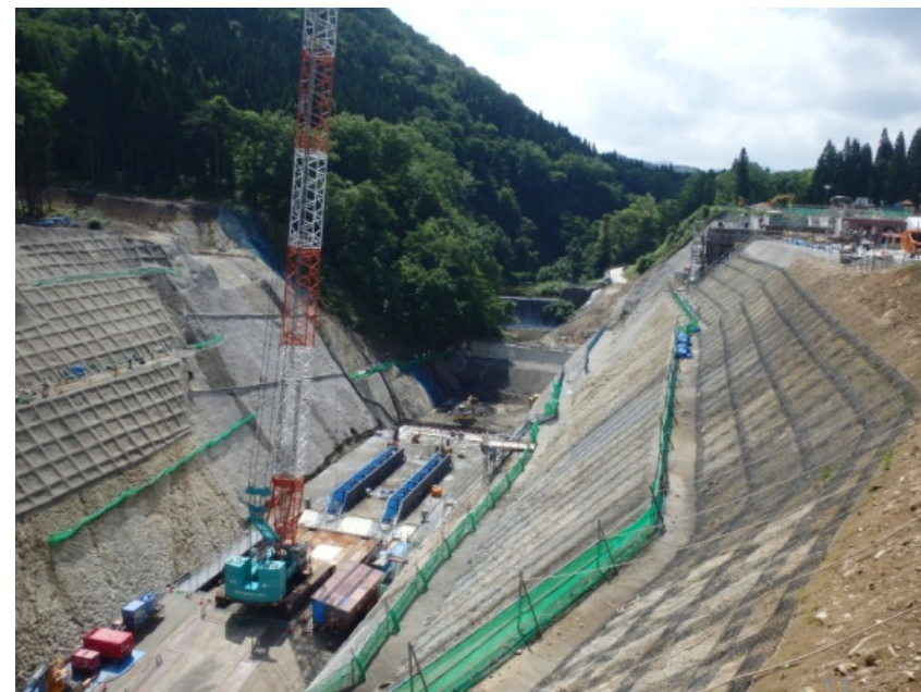
堤体コンクリート打設状況（上流より）
