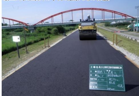
最上川水系元宿川の事例(堤防裏法尻の補強)
