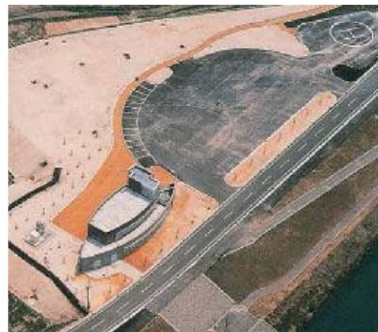
真室川町河川防災ステーション（整備済）
