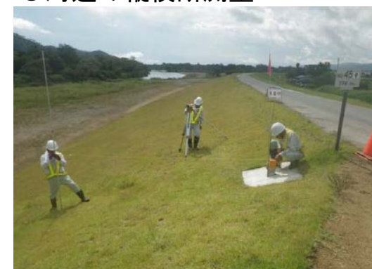
定期横断測量状況
