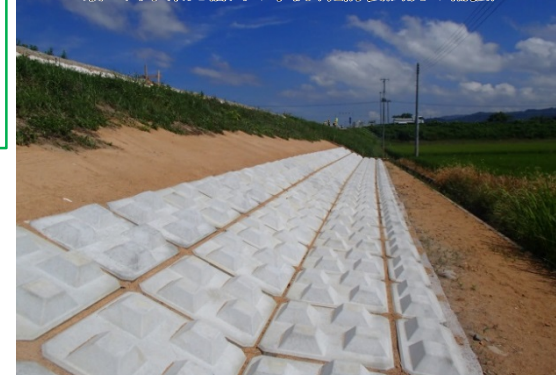
最上川水系元宿川の事例(堤防裏法尻の補強)
