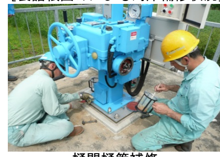
樋門樋管補修 [経年劣化による開閉器補修]
