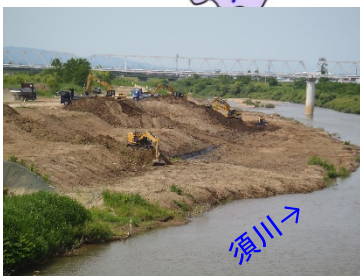
河道掘削の施工状況
