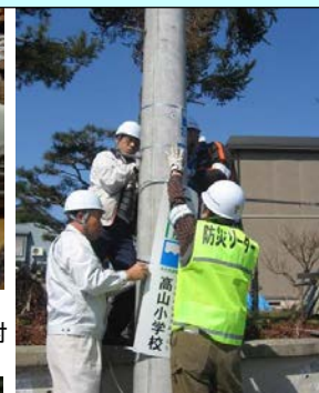
標識の設置（川西町）
