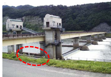
最上川さみだれ大堰
