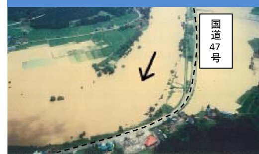
整備後：平成25年7月洪水
