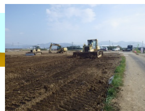
掘削土砂敷均し (南陽市)
