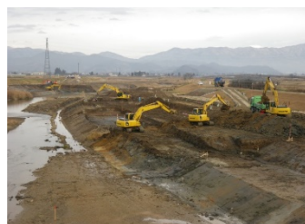
河道掘削状況 (南陽市)
