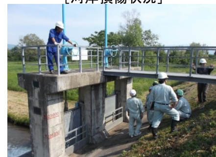
樋門樋管点検
