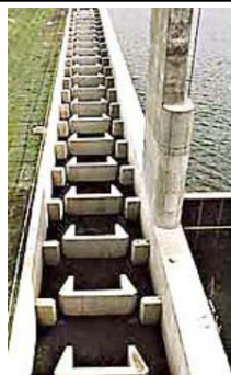
下流側から見た魚道
