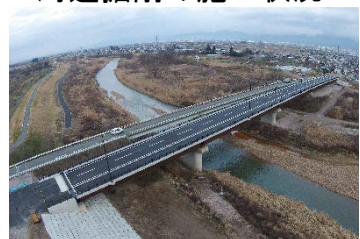
飯塚橋の架け替え (平成28年3月完成)
