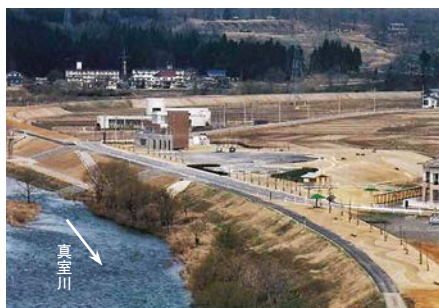
防災ステーション全景
