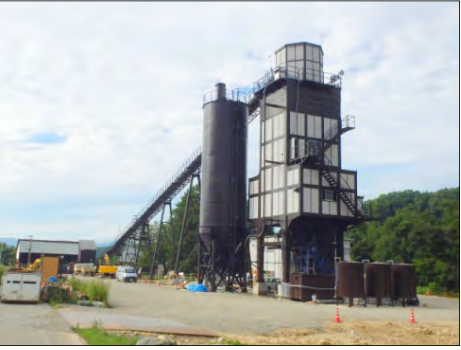
仮設備 (バッチャープラント等)
