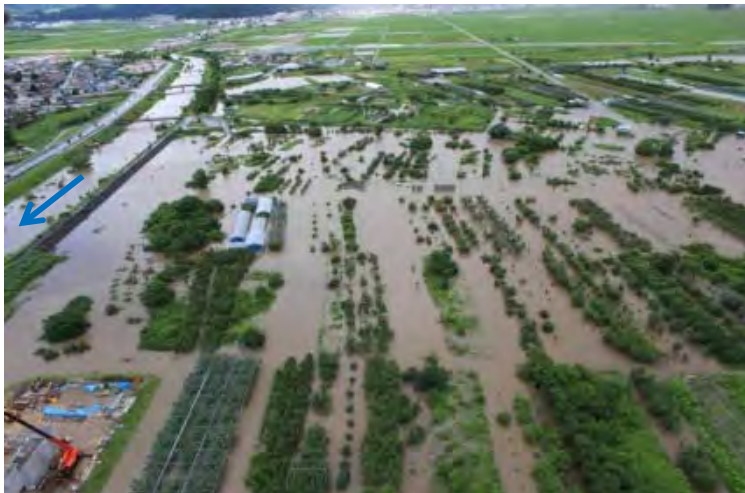
大旦川【村山市】 H25年7月の被害状況
