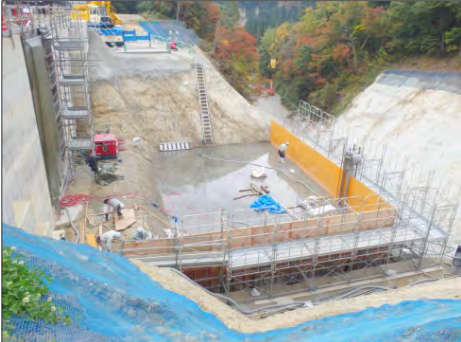
堤体工 (コンクリート打設)
