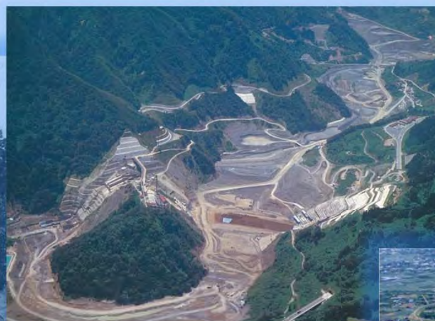
▲寒河江ダム施工中 (着工昭和47年／完成平成2年)
