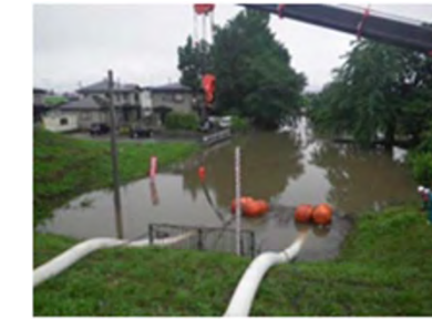
須川の増水による内水状況 (山形市志戸田地区)
