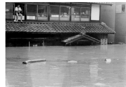
最上川の増水による家屋浸水状況 (戸沢村古口地区)
