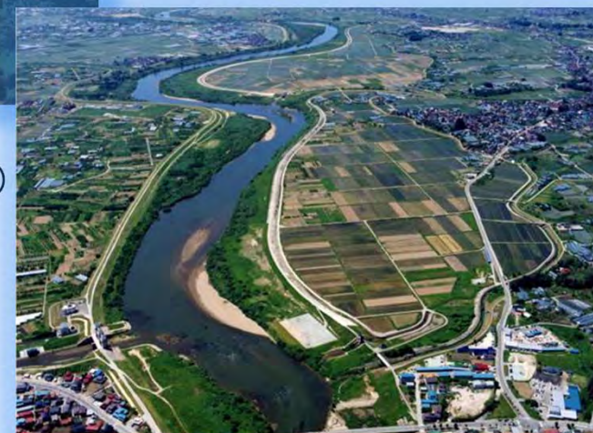
▲大久保遊水地 (着工昭和50年／完成平成9年)
