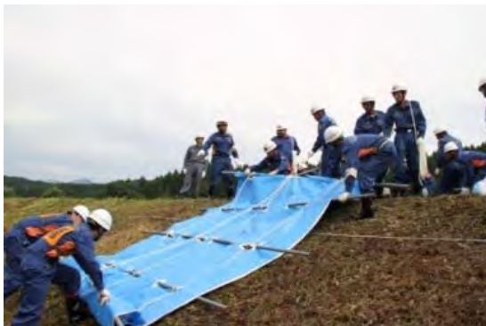
【最上川中流】シート張り工の訓練実施(真室川町)
