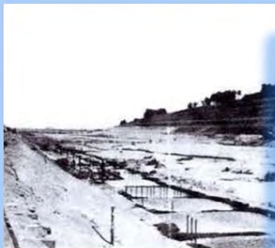
▲赤川放水路開削工事の様子 (着工大正10年／通水昭和11年)
