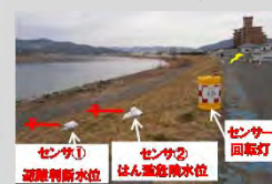
クッションドラムに回転灯を付けた水位上昇を知らせる簡易アラートの設置を行う。
