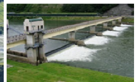
最上川さみだれ大堰
