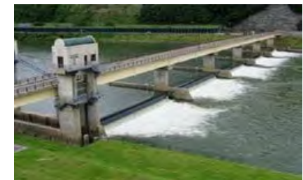
最上川さみだれ大堰
