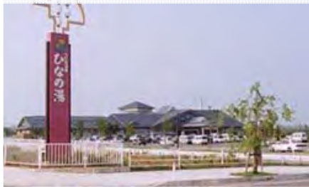
町営温泉施設
