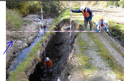
一般県道最上小野田線（最上町富沢地内） 路面流出
