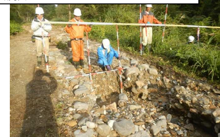
一般県道最上小野田線（最上町富沢地内） 路面流出
