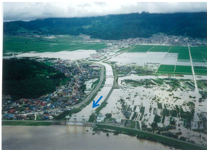
大旦川【村山市】 H14年7月の被害状況
