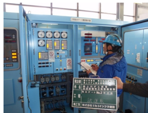
ゲート設備点検
