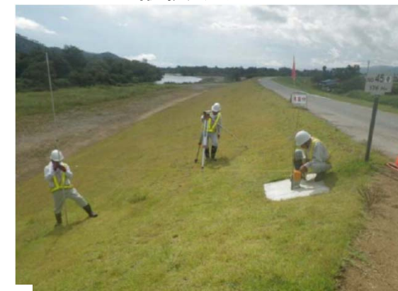
定期横断測量状況
