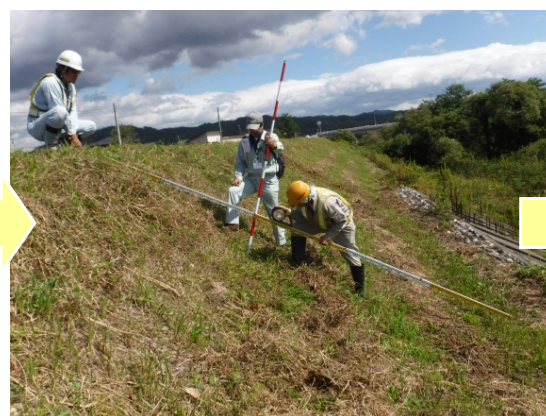
除草後の堤防点検
