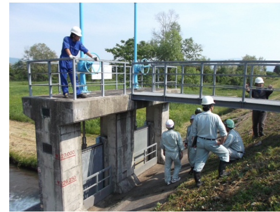
樋門樋管点検
