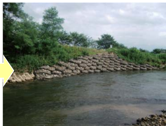
河岸補修後 [袋詰根固めによる河岸補修状況]
