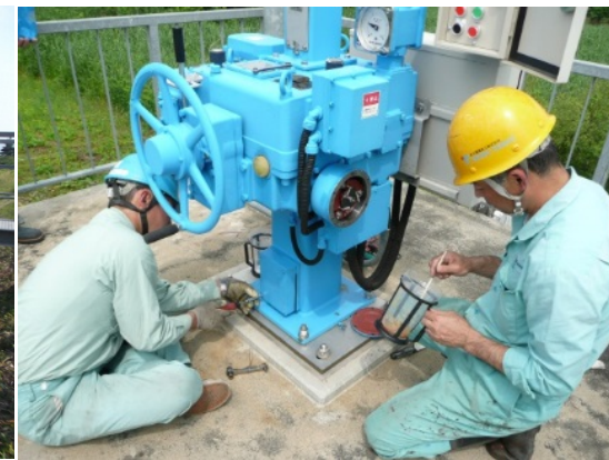
樋門樋管補修 [経年劣化による開閉器補修]
