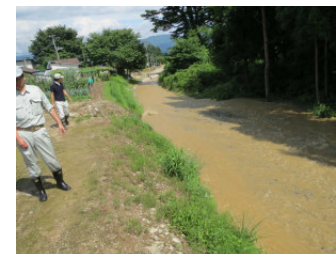
小鮎貝川河川埋塞状況
