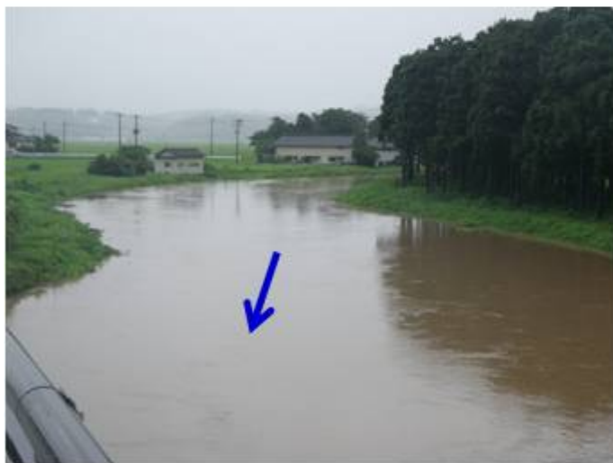
H25.7出水状況
