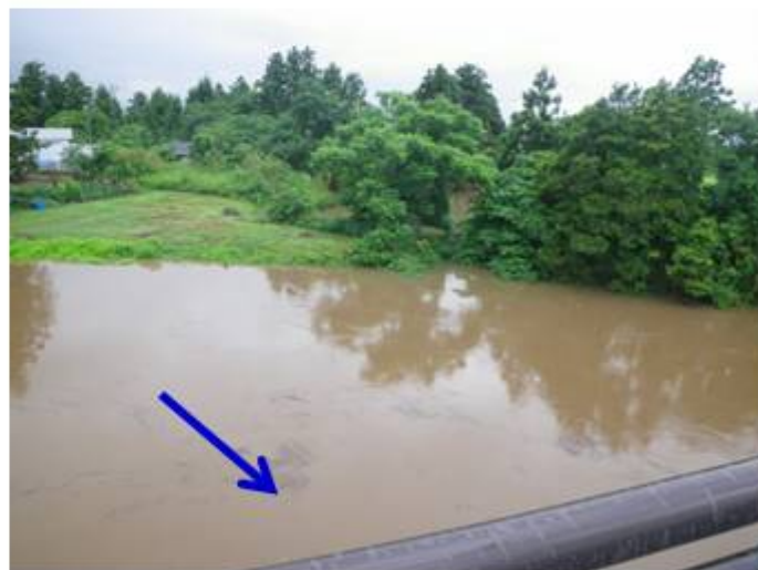
H25.7出水状況
