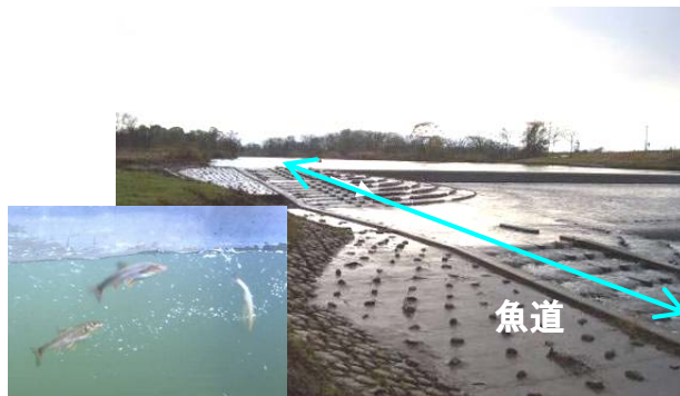
堰や落差工に設けた「魚道」の事例
