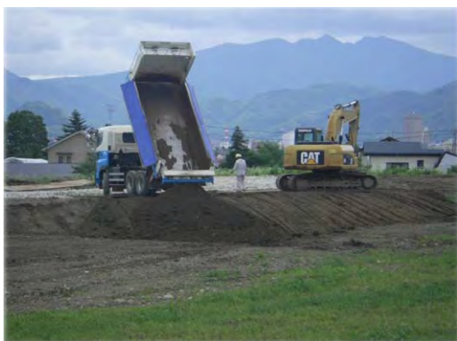
河岸掘削土砂仮置き状況 (発生土の発生)
