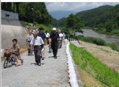
トロッコ道（管理用通路）
