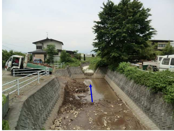
30. 橋梁より下流を望む
