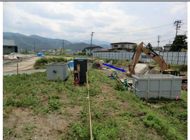
11. 八貫橋より上流を望む (工事中区間)
