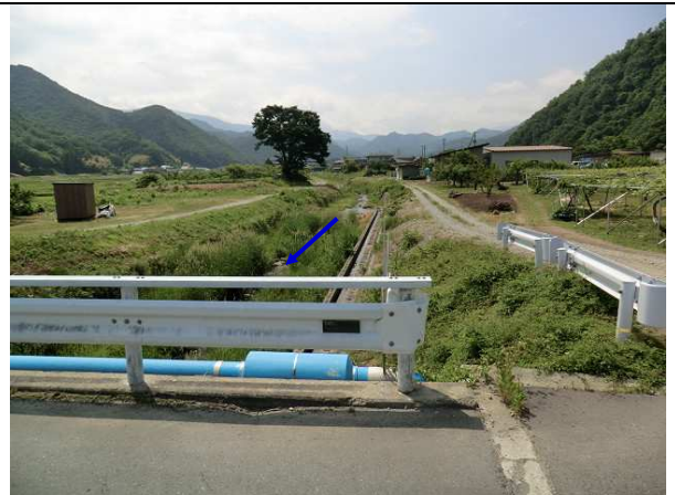
6. 三宝岡橋より上流を望む (完成断面区間)
