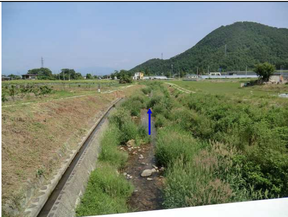
5. 三宝岡橋より下流を望む (完成断面区間)
