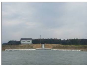
取水施設(岩ヶ袋工区)
