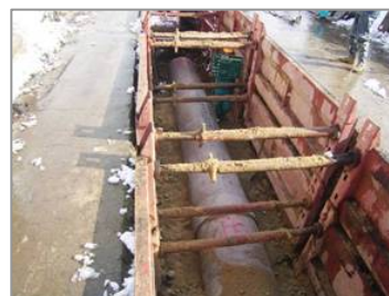
導水路(岩ヶ袋工区)
