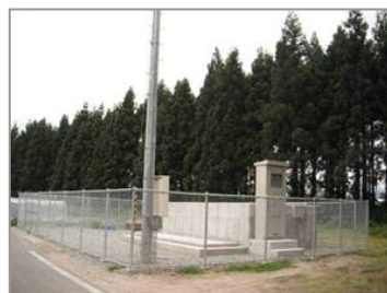
着水槽(岩ヶ袋工区)
