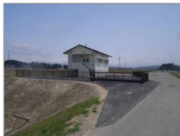
操作室(岩ヶ袋工区)
