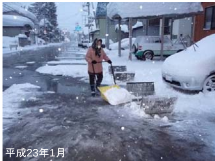
導水することで、円滑な除雪が可能になり、雪堤により阻害されていた歩行空間が復活した。
