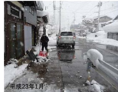
導水することで、雪堤排除が可能となり、交通が円滑化した。
