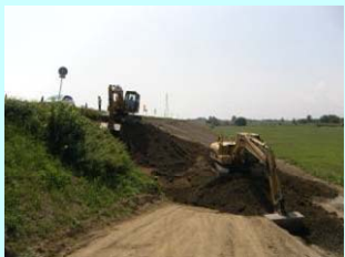
堤防拡幅状況 (河北町大富地区)
