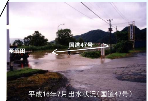
平成16年7月出水状況(国道47号)
