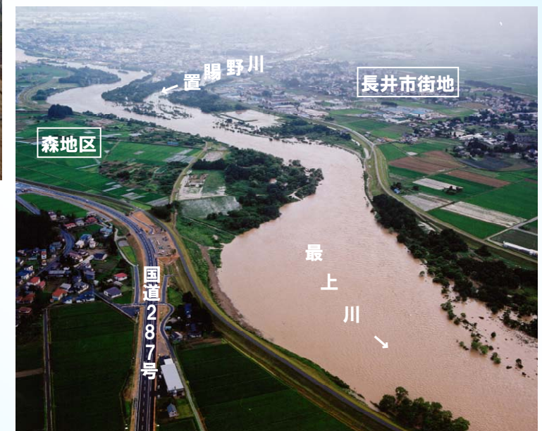
平成14年7月洪水出水状況
