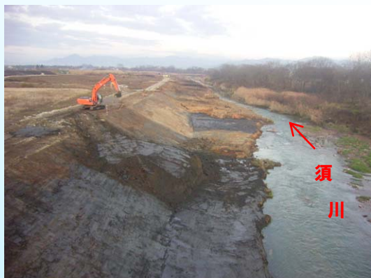
河道掘削状況 (山形市中野目地区)
