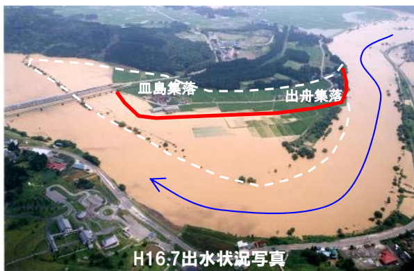
中流部改修事業（右岸：血島地区）
