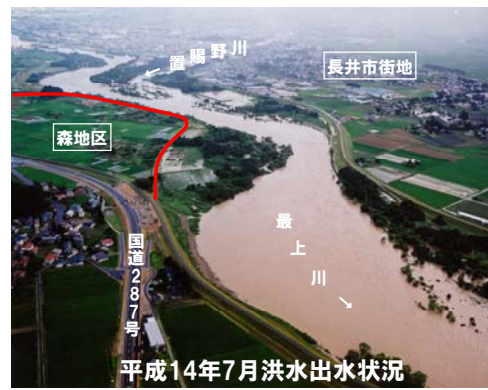
上流部改修事業（右岸：森地区）
