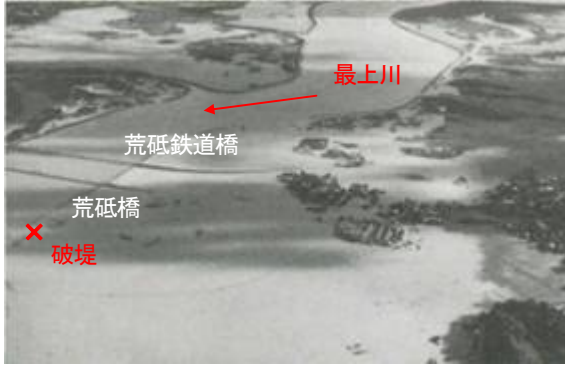
荒砥橋付近における破堤状況（白鷹町箕輪田地区）
