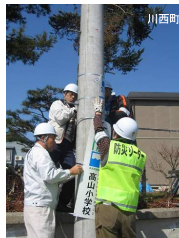
標識の設置状況
