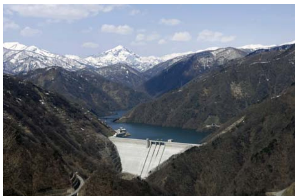
長井ダム（平成23年完成）
