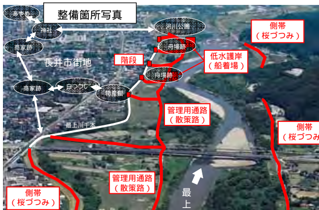
整備内容…管理用通路、管理用階段、低水護岸、側帯 等
