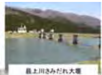
最上川さみだれ大堰
