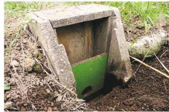
排水柵に調整板を設置した様子
