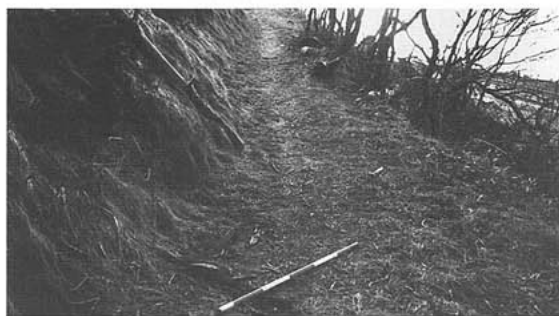
写真1 滝ノ浦集落公民館の上方にみられた砂丘砂被覆層の地割れ。幅約20cm長さ約3m。ものさしは0.2m間隔。下は国道。3.10撮影
