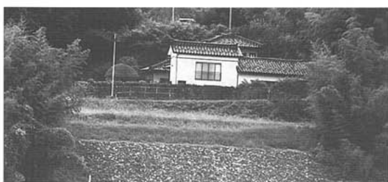
写真5 同 蛇籠によって復旧工事後。99.8.27
