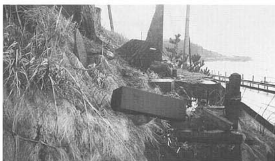
写真2 滝ノ浦集落付近の砂丘砂斜面の上の墓石の倒壊
