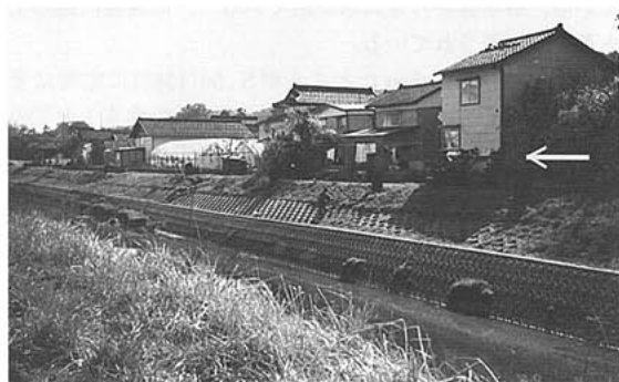
写真7 田地下, 江地橋上流の西通り川ぞい。右(北)側2階建て倉庫と隣の住宅が被害をうけた。 4.17撮影
