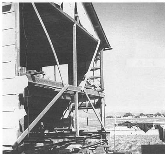
写真8 同 改修中の倉庫。 4.17
