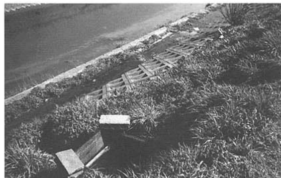
写真9 河岸上部の湧水。池として魚を飼っている。護岸は2段あるが、湧水のある部分にのみ、犬走りに水がしみだしている。
