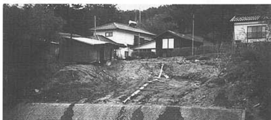
写真4 月光川沿いの砂丘麓部の地すべり。
