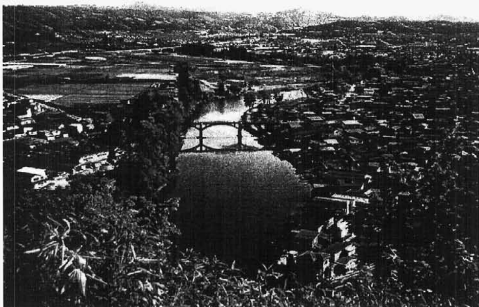
写真7 大江町日本一公園からみた最上川橋
