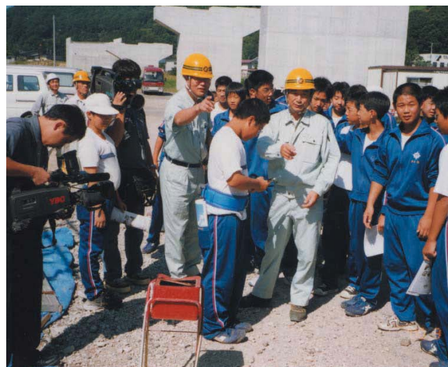
工事現場での見学の様子
