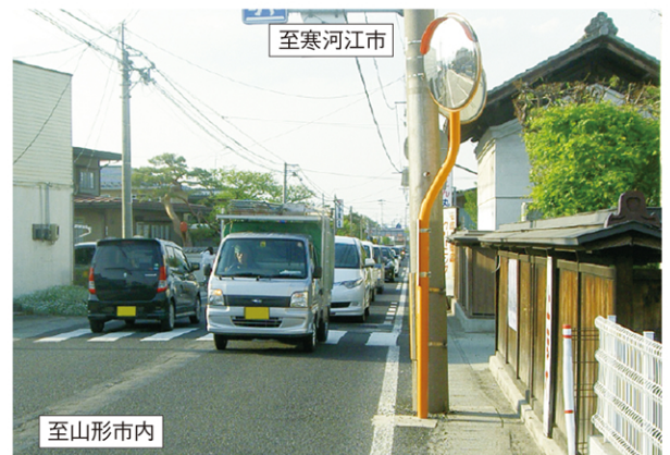
国道112号下条地区の右折車が直進車を阻害している状況
