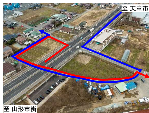
▲右折レーンがないため大きく迂回する状況
