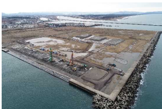
▲岸壁の整備状況
