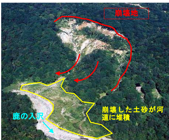
▲角川流域鹿の入沢で発生した崩壊(H6)
