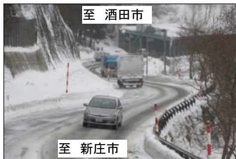
▲急カーブ、路面凍結状況
