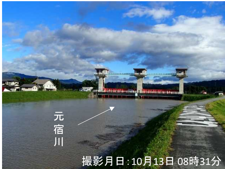
もとじゅくがわ 元宿川水門 もとじゅくがわ 最上川水系 元宿川右岸堤防より
