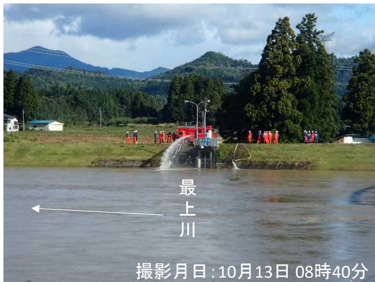
最上川 県道248号上伊佐沢川西線松川橋下流(185.7k付近) 排水作業状況
