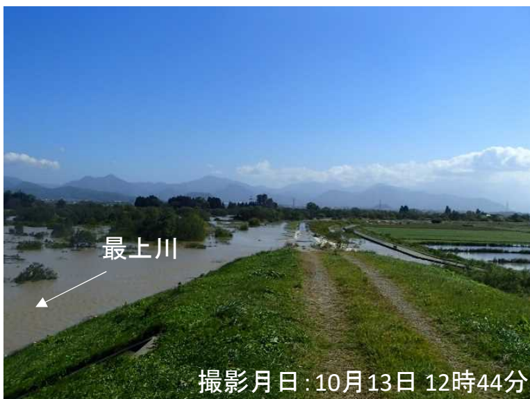
最上川 左岸 108.1k付近 大久保第二遊水地越水状況
