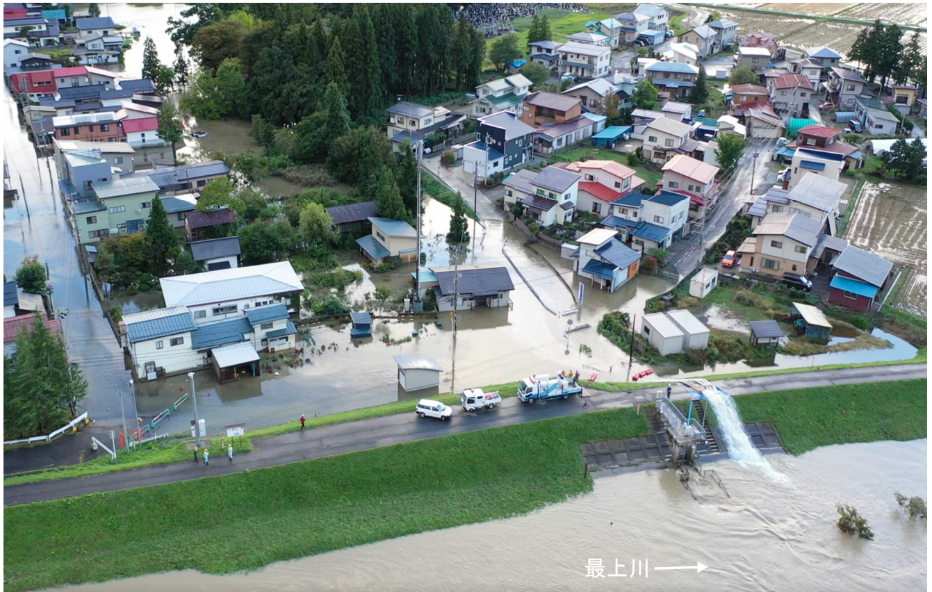
▲糠野目地内 排水ポンプ車稼働状況
