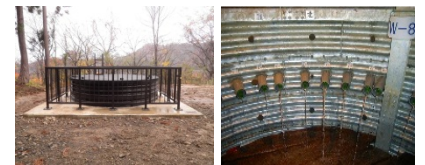
集水井整備状況
