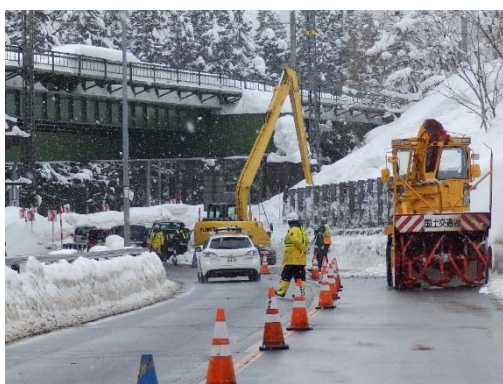
片側交互通行規制を伴う雪崩・落雪予防作業
