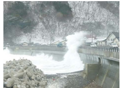
▲国道7号の越波状況
