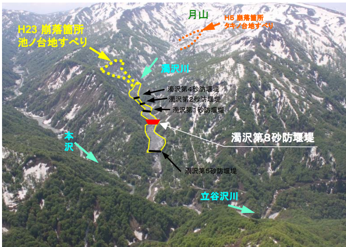
大規模崩壊後の立谷沢川流域濁沢
