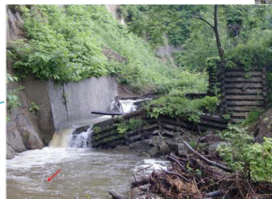
横道沢第1砂防堰堤損傷状況
