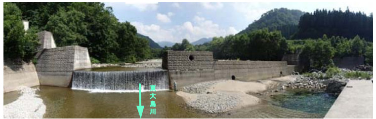
東大鳥川砂防堰堤
