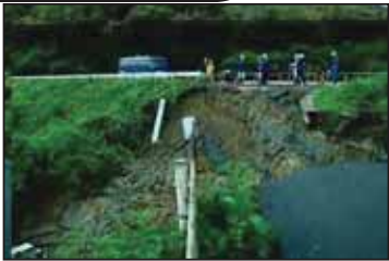
▲国道13号 H14.7.11 土砂崩落 (事前通行規制実施中に被災) 平成28年度予算の充当により、トンネル工事、改良工事、舗装工事、道路付属物工事を推進し、早期開通に向けて着実な事業進捗を図ります。
