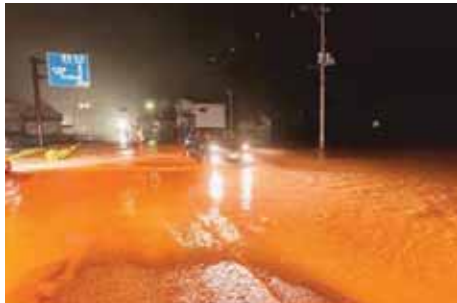
▲国道47号新庄市本合海地区の被災状況
