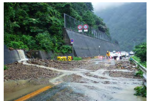
▲国道47号猪ノ鼻地区の被災状況
