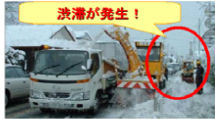
▲運搬排雪状況
