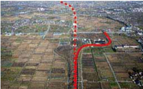
▲整備が進む東根～尾花沢（東根 I C 付近）
