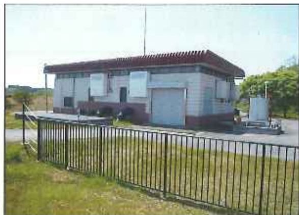
津花川排水機場 (高瀬川河川事務所所管施設)
