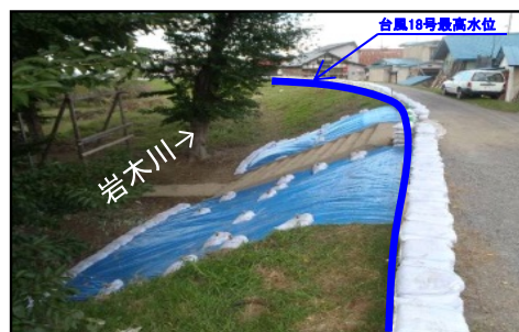
緊急土のう設置状況(H25.9月洪水)
