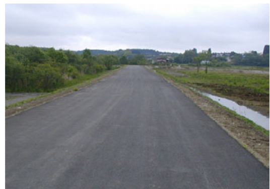
舗装後の状況
