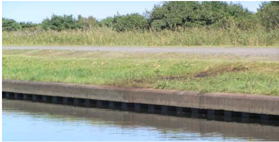
矢板護岸の状況：仏沼地区
