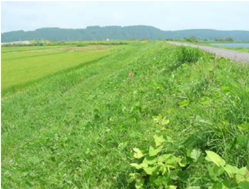
堤防法面に雑草が繁茂している状態
