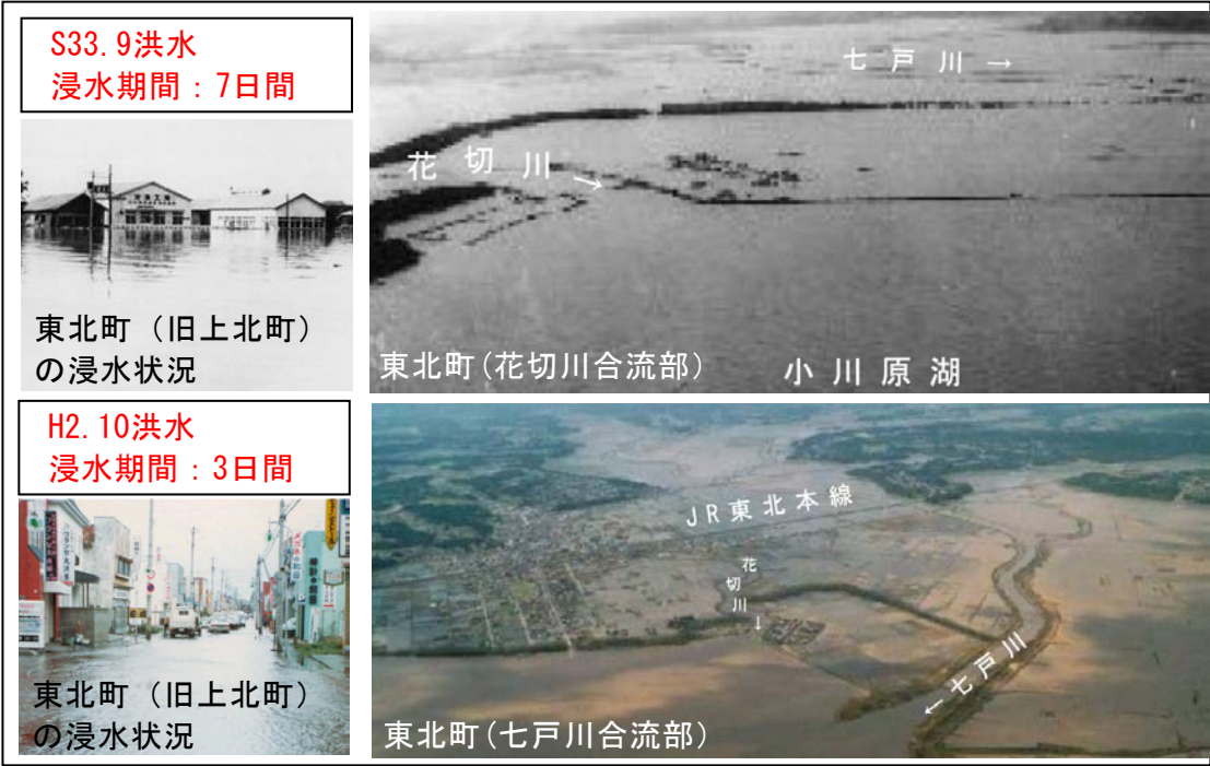
高瀬川流域の主要な洪水状況
