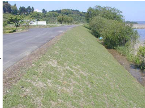
堤防法面の除草後
