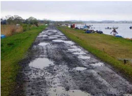
舗装前の状況
