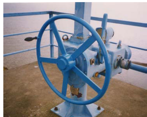
開閉器ハンドル補修後
