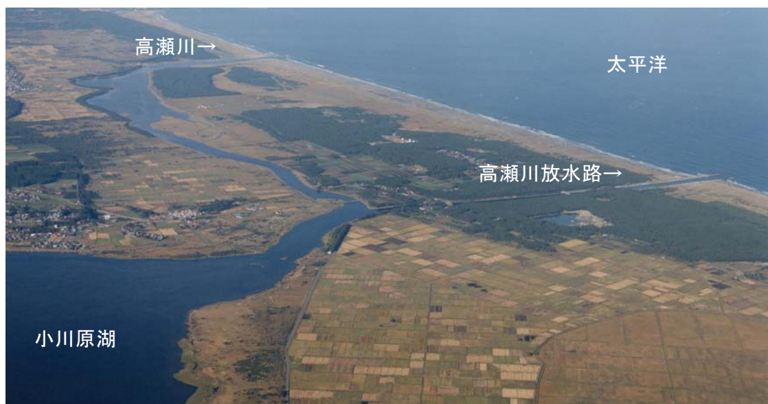
現在の高瀬川放水路の状況
