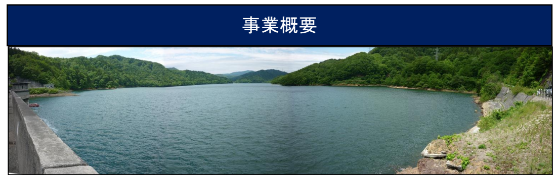
農業用水を貯水した天間ダム
