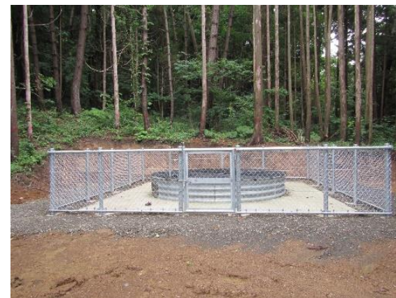
【地すべり防止工】
