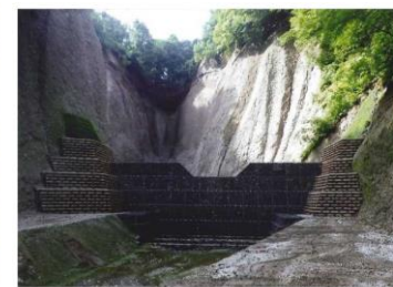
【治山：溪間工（治山ダム）】
