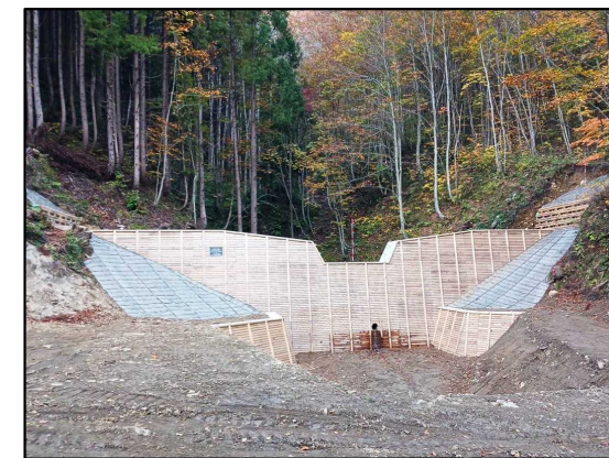
治山施設・谷止工
