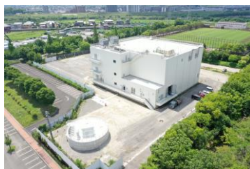
雨水ポンプ場
