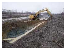
河道掘削 (石狩川水系、北海道開発局)
