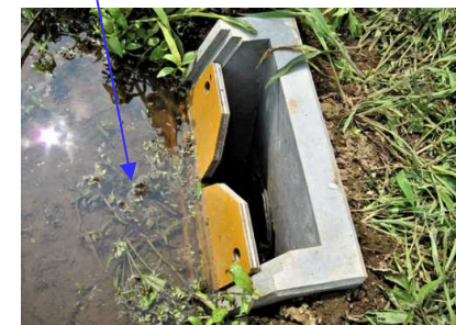
水位調整板の設置イメージ
