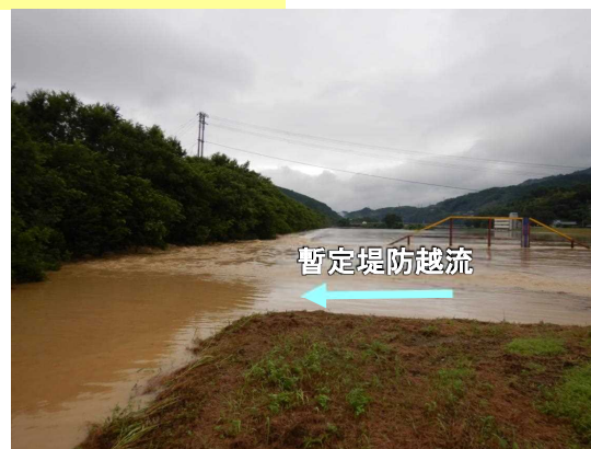
暫定堤防越水状況
