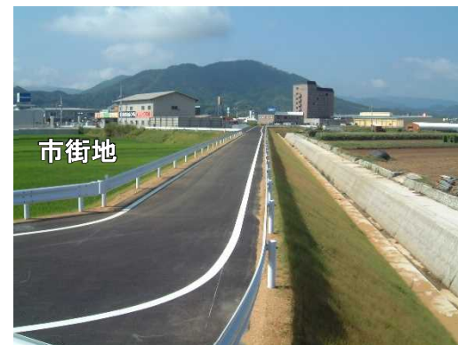
二線堤整備状況
