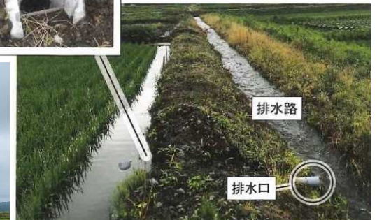
堰板による止水状況
