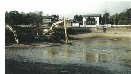
＜ため池の浚渫工事＞
