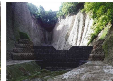
【治山：溪間工（治山ダム）】
