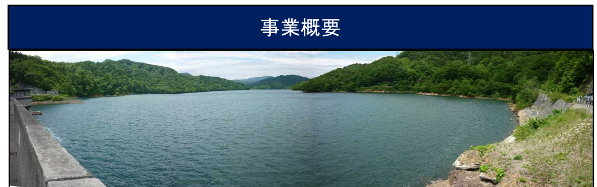
農業用水を貯水した天間ダム
