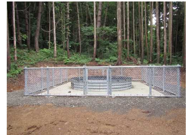
【地すべり防止工】
