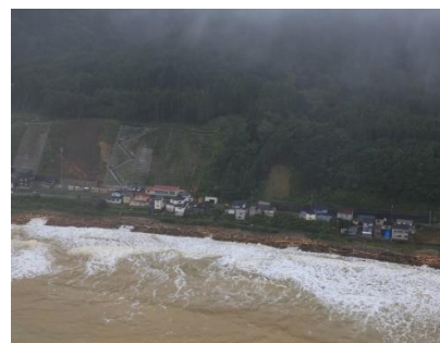
8月11日 海岸流木状況 (甲海岸) 撤去作業中
