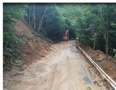
8月18日 むつ恐山公園大畑線 地元業者による道路啓開 の復旧作業状況
