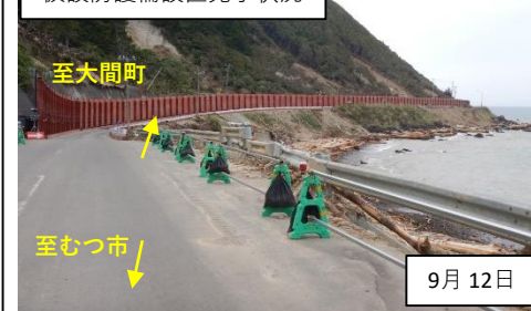
易国間～下風呂間 仮設防護柵設置完了状況
