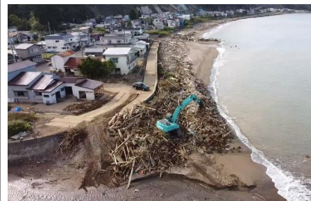
9月9日 甲海岸 流木撤去作業着手
