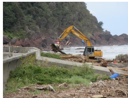
9月6日 釣屋浜海岸 流木撤去作業着手
