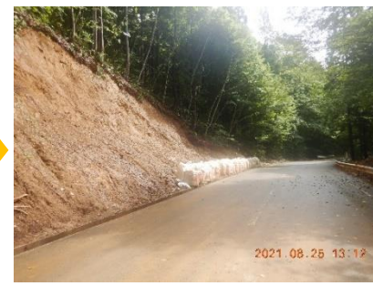
8月25日 むつ恐山公園大畑線 道路啓開作業完了後の 規制解除状況
