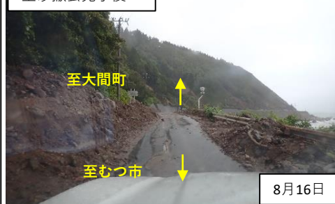
焼山崎～下風呂間 土砂撤去完了後
