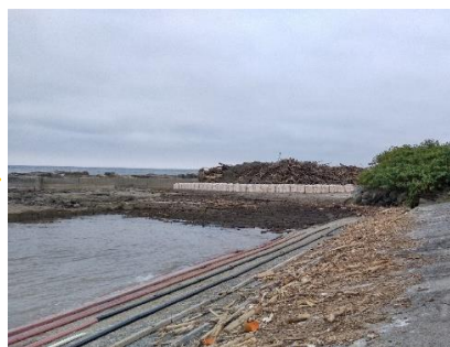
8月22日 甲海岸船揚場 流木撤去完了
