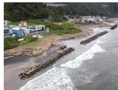
8月24日 海岸流木状況 (釣屋浜海岸) 撤去作業中
